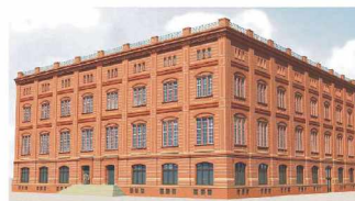
SCHINKELSCHES BAUAKADEMIE INTERNATIONALES INNOVATIONS-, AUSSTELLUNGS-, VERANSTALTUNGS- UND KONFERENZZENTRUM (SCHINKELFORUM: INTERNATIONALES ZENTRUM FÜR DIE VERANTWORTUNGSBEWUSSTE GESTALTUNG VON LEBENSÄRÄUMEN)
