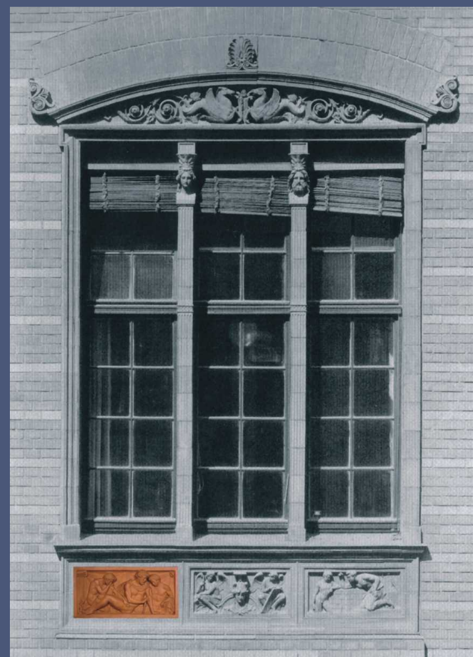
Bauakademie, Südfassade, 5. Fenster, 1. Obergeschoss
